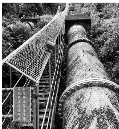
写真－6 旧管(右)、新管(左)
